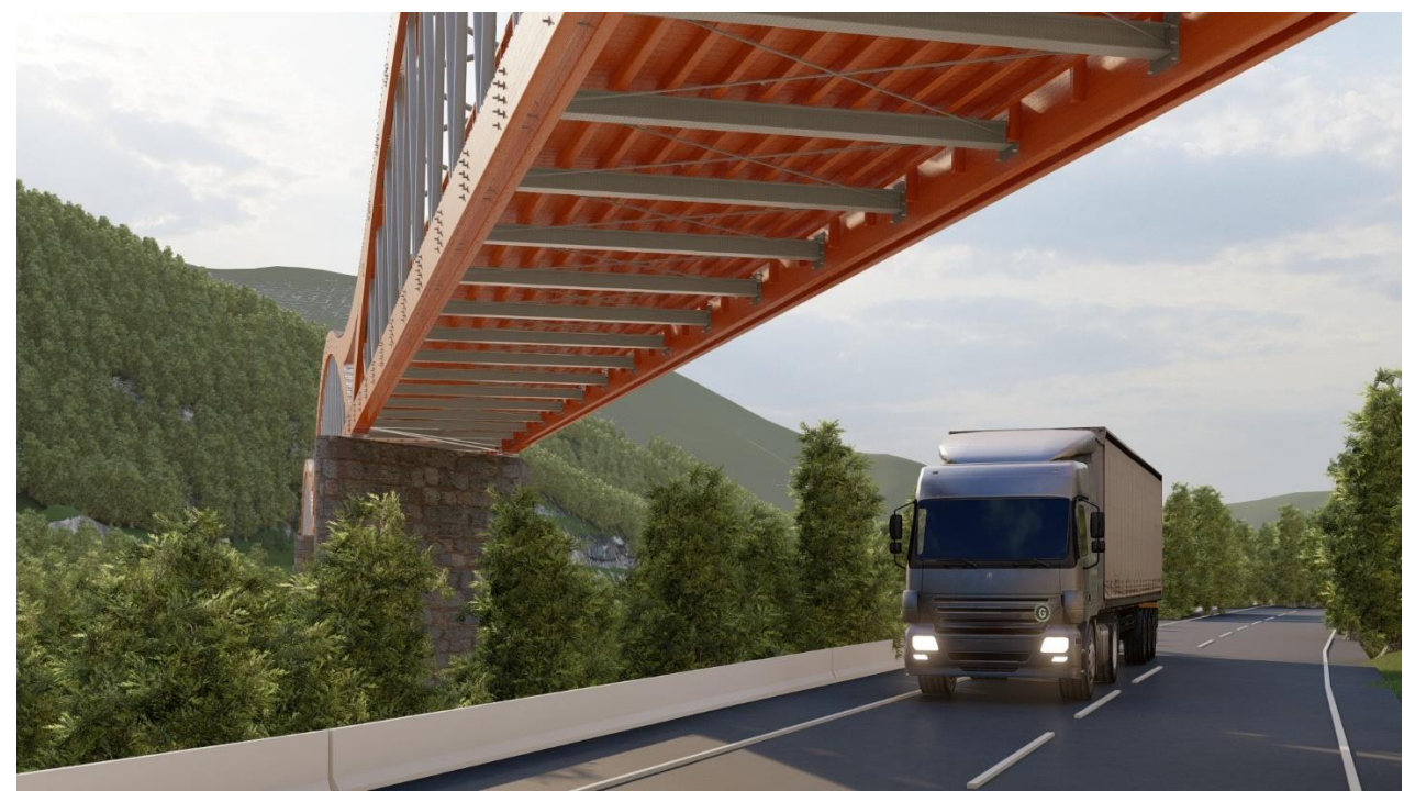
Ilustración 4. Vista desde la carretera
